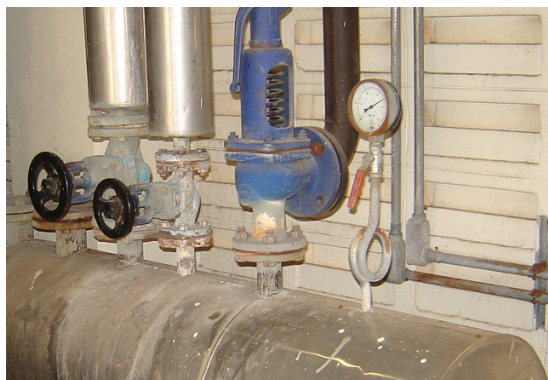
รูปที่ 11.7 การติดตั้งมาตรวัดความดันผ่านท่อชุด
